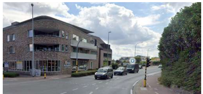
Hoekgebouw ('Onze Keuken') en CM-kantoor
